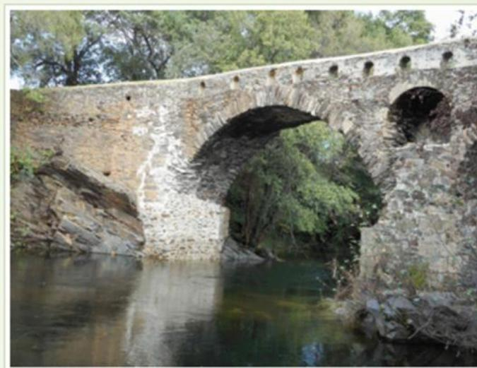
El criterio para estas intervenciones es la consolidación de las fábricas y la reposición de las zonas perdidas, utilizando materiales tradicionales similares a los existentes en el entorno, como pizarra y empleo de mortero de cal, conservando el carácter de las distintas partes del puente con sus irregularidades.
