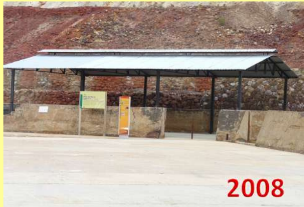
Adecuación para la visita y señalización
